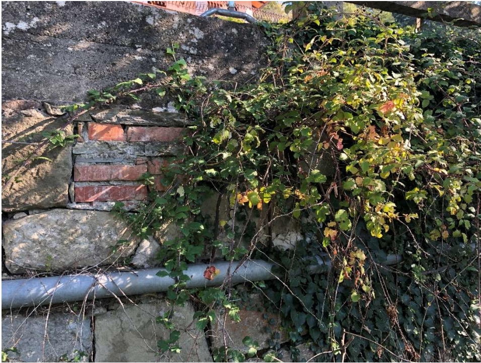
Figura 3 Tubo camicia fissato al paramento del muro a valle della strada, nel tratto a sud.
