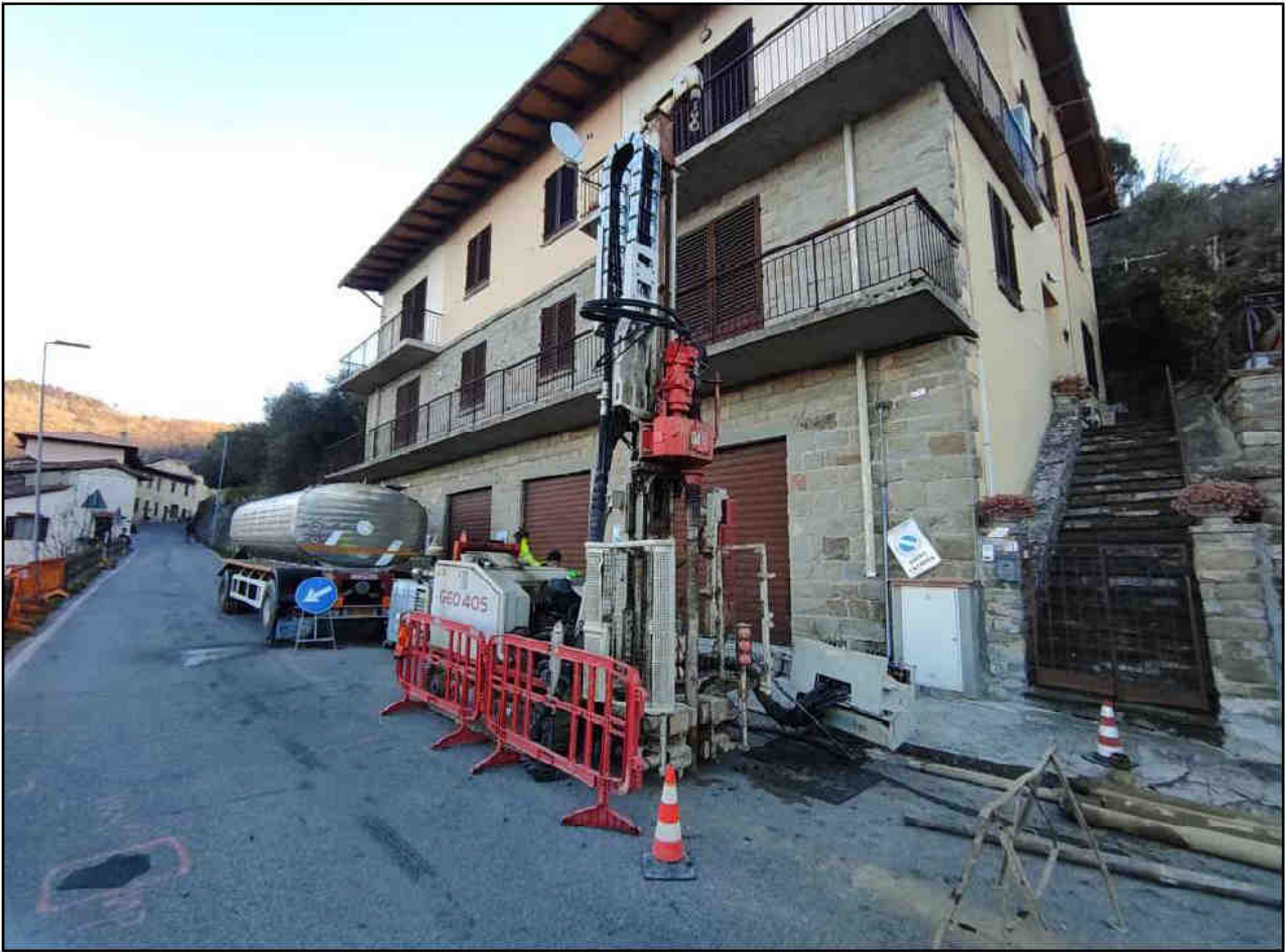
Figura 1: Postazione del sondaggio S1-IN
