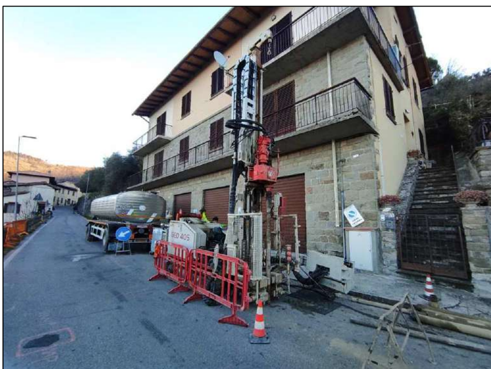
Figura 1: Postazione del sondaggio S1-IN
