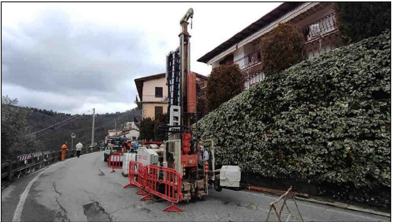
Figura 10: Postazione del sondaggio S2-DH
