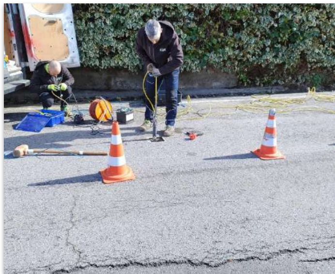
FIGURA 2 FASE DI PREPARAZIONE DELLA PROVA DOWN-HOLE E STRUMENTAZIONE ADOPERATA
