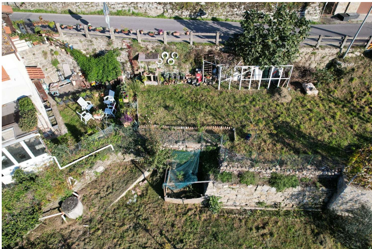
Figura 18 Scala da demolire a fianco alla casa (sx)
