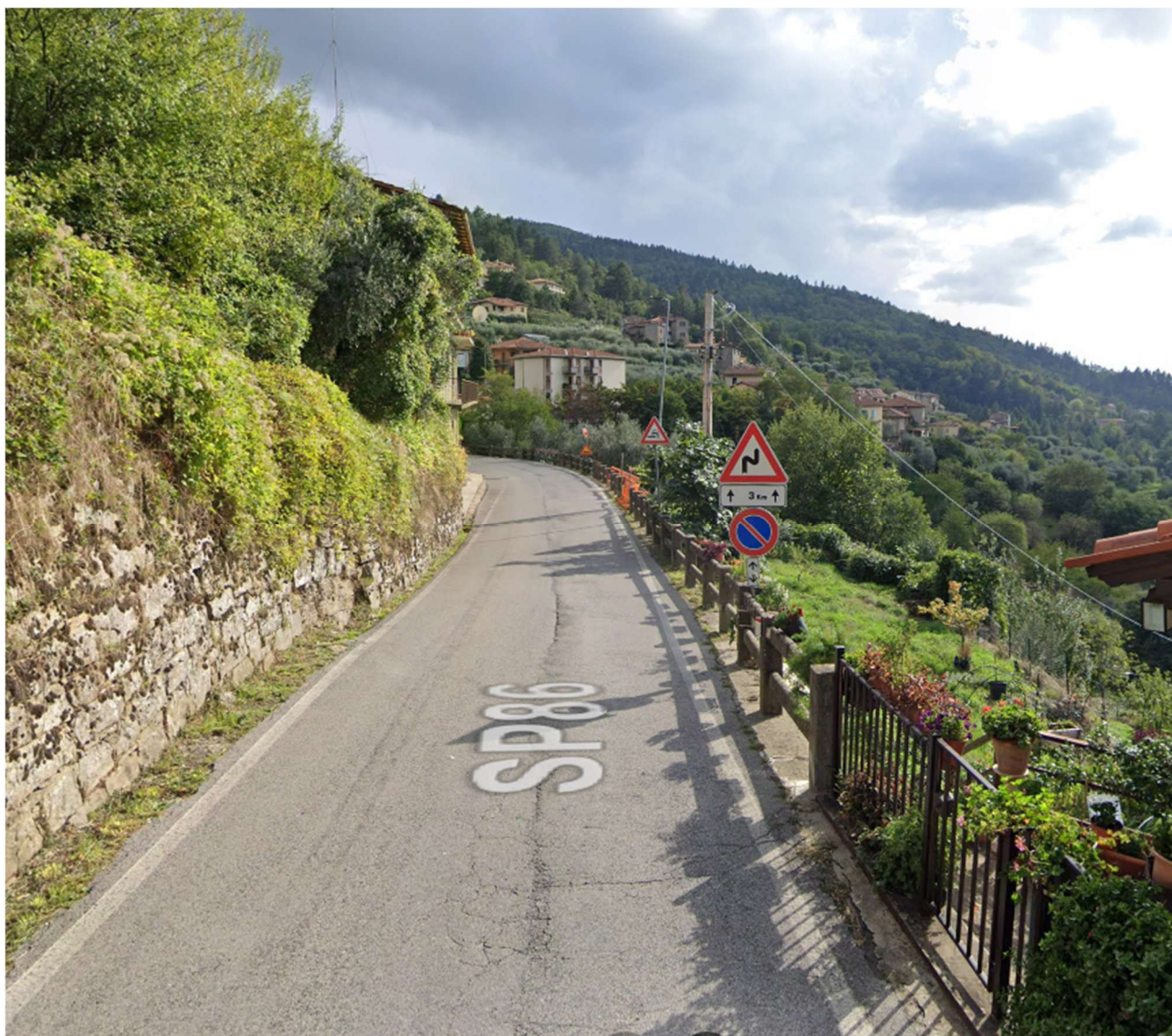
Figura 17 Parapetto e segnaletica verticale esistente
