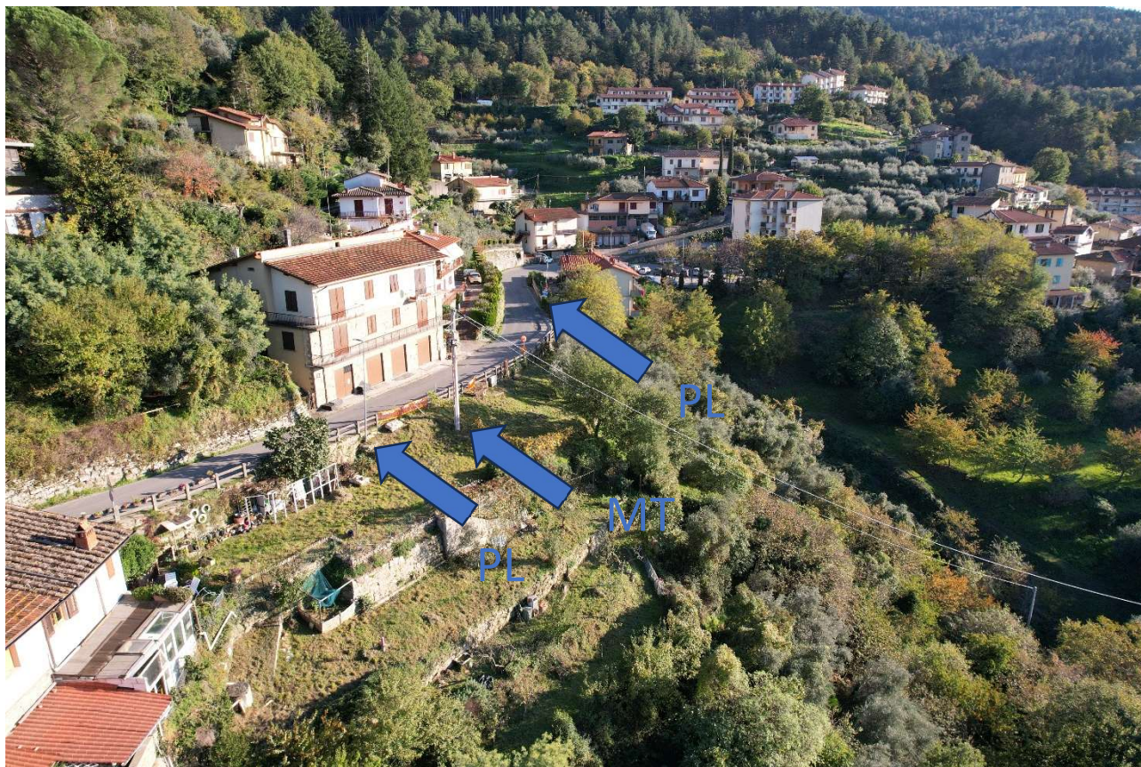
Figura 20 Pali illuminazione pubblica e palo media tensione
