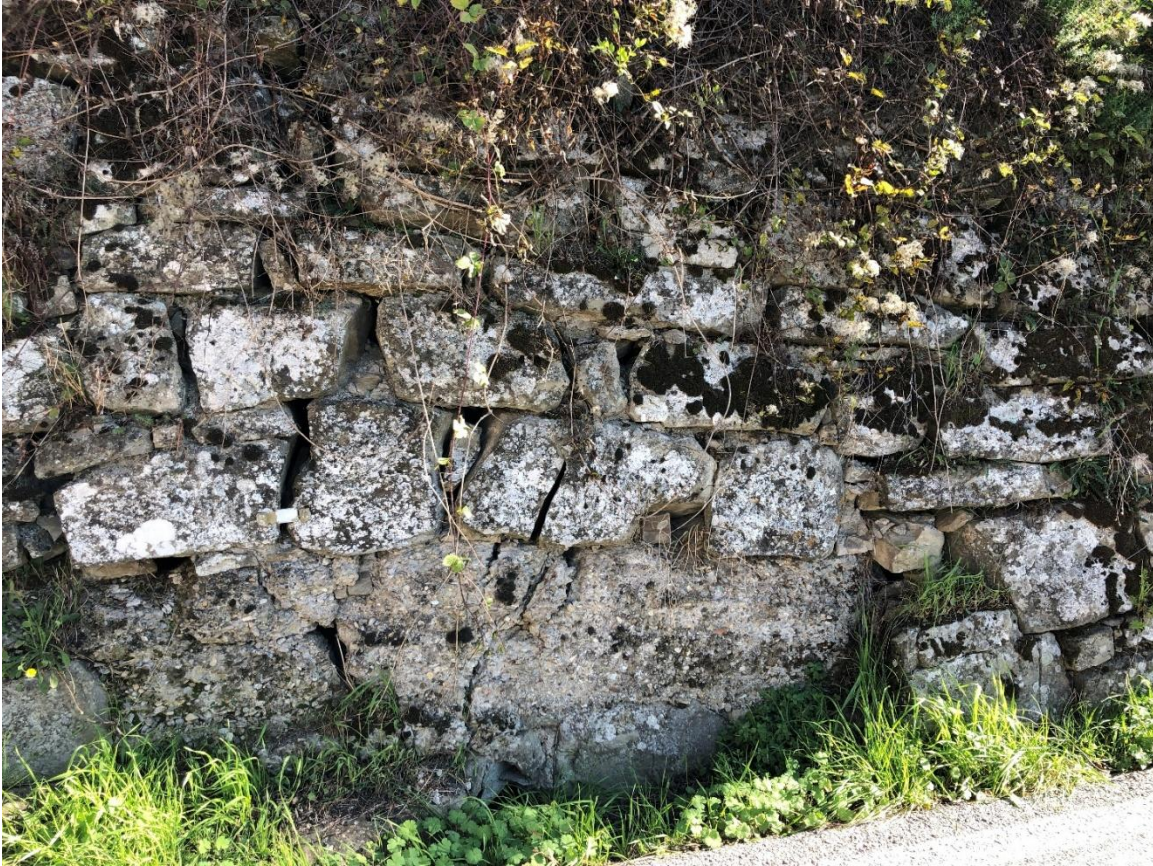
Figura 10: Particolare del muro a nord
