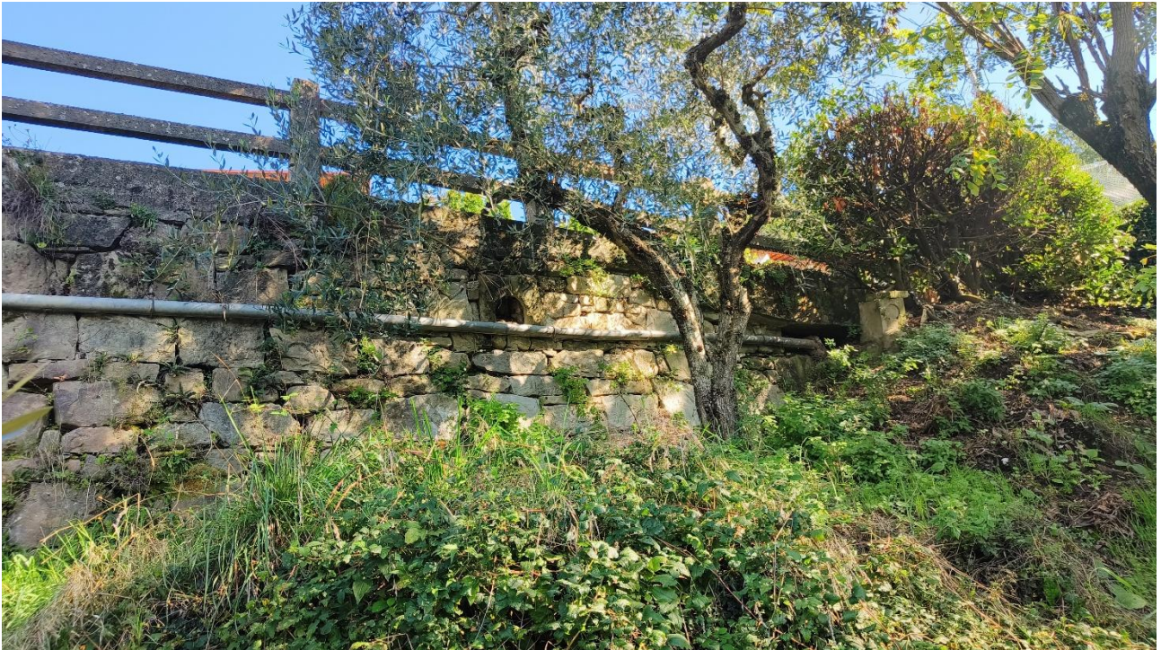
Figura 14: Muro di sostegno lato valle
