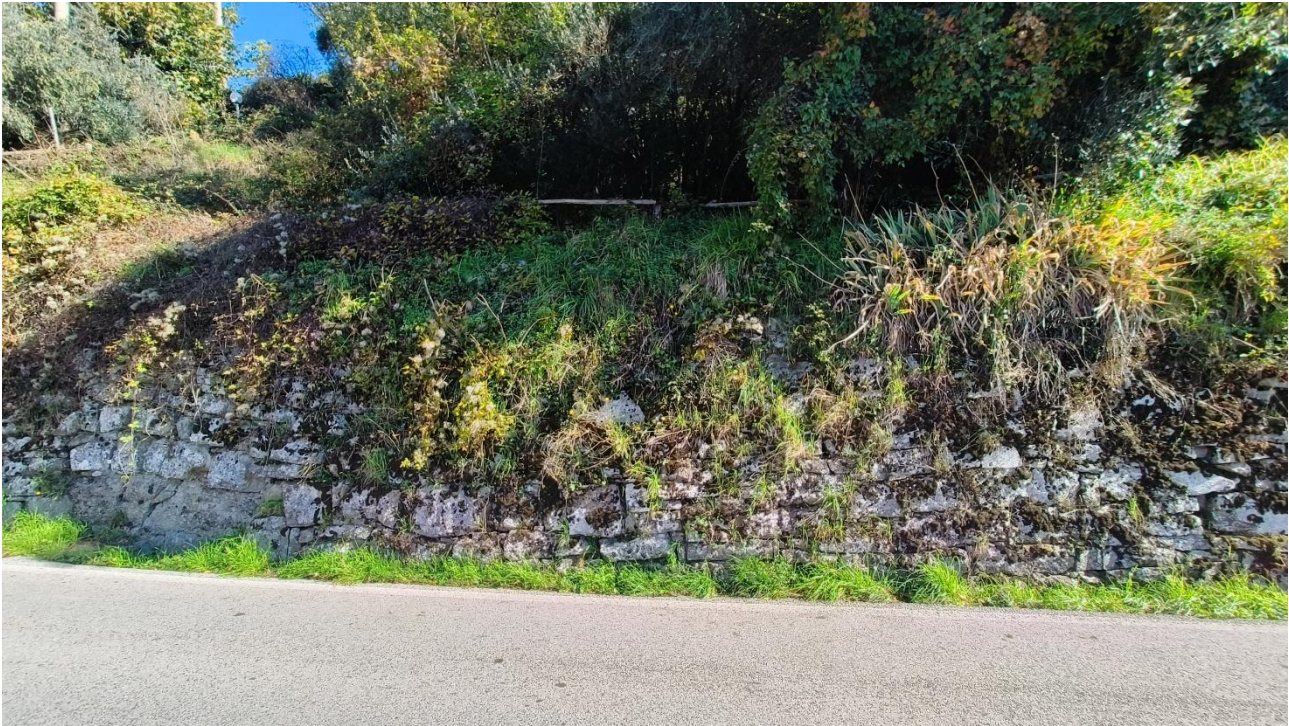
Figura 11: Prospetto del muro a nord
