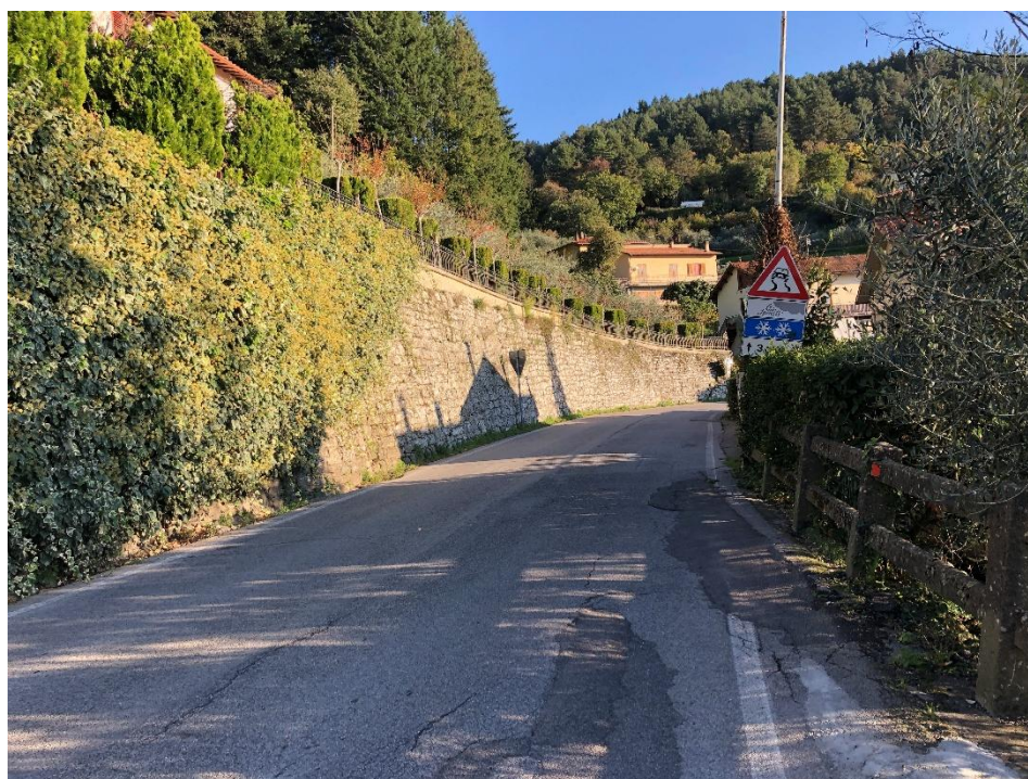
Figura 13: Zona sud, vista da nord
