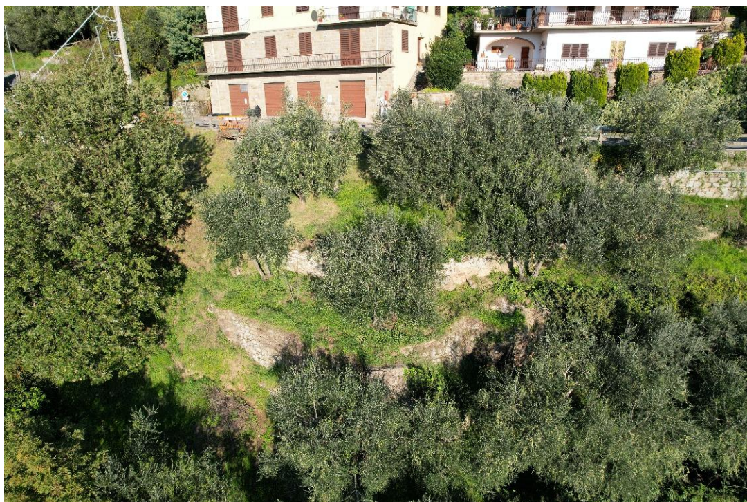
Figura 16: Vista aerea del versante, particolare davanti alla ex caserma dei carabinieri.
