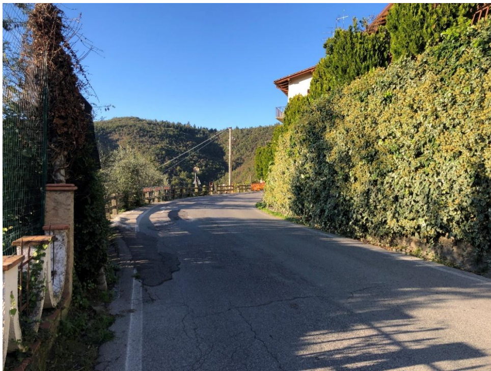
Figura 12: Zona sud, vista da sud
